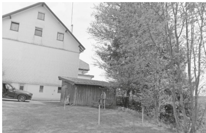
Ortsteil Kappel unterhalb vom ehemaligen Hotel Pfauen
