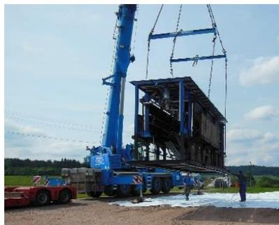
Die Anlage wird vom Tieflader auf die Weide gesetzt. Die Anlage kann auch mit Rädern ausgerüstet werden.
